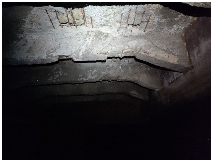
Foto 1. Beton exfoliat din placa de suprabetonare - armatura corodată
