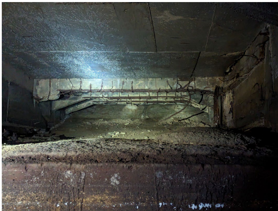
Foto 10. Serie de antretoaze cu armaturile expuse, ruginite
