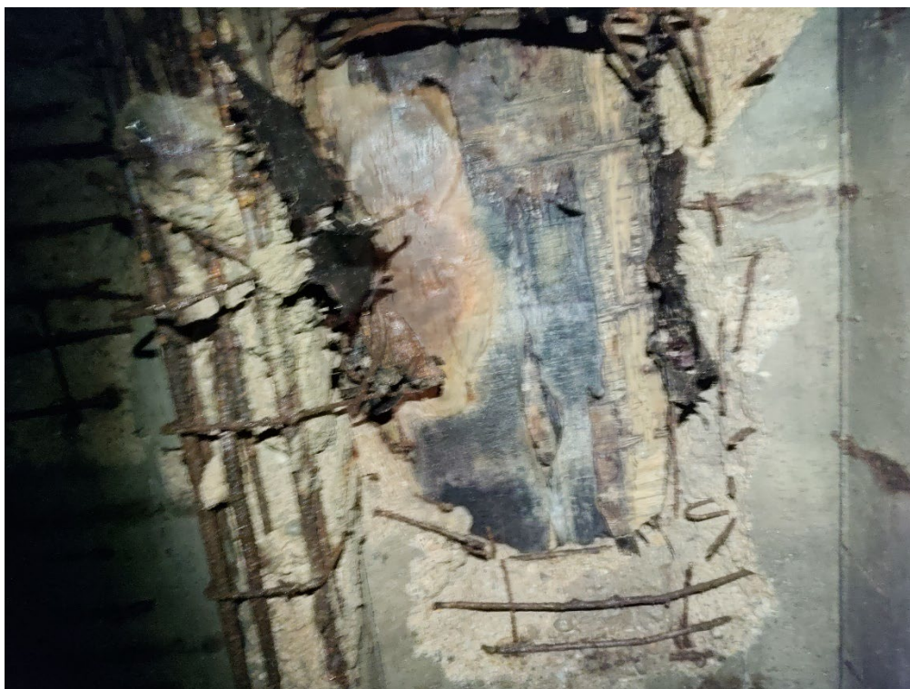
Foto 7 – Zona de placa distrusa, armatura din antretoaze complet expuse
