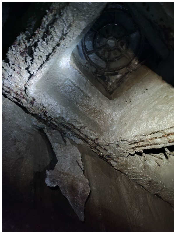
Foto 1. Beton exfoliat din placa de suprabetonare - armatura corodată
