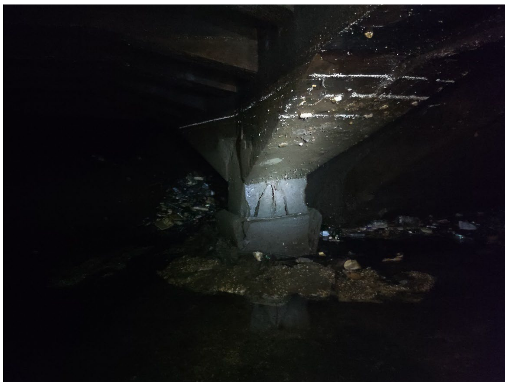
Foto 7 – Zona de placa distrusa, armatura din antretoaze complet expuse
